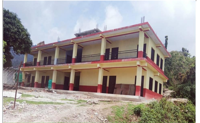
श्री ज्ञानोदय प्रा.वि. भेरी न.पा.-५ ईवर ४ कोठे भवन निर्माण, जाजरकोट
